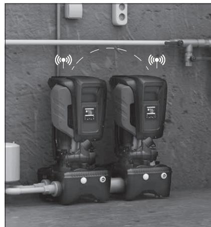
Nel caso di installazione multipla, dopo aver montato la base e posizionato i componenti, le pompe comunicano autonomamente in modalità wireless.
