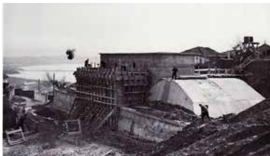
FOTOGRAFIA ORIGINALE D'EPOCA DURANTE LA COSTRUZIONE DELL'ACQUEDOTTO
